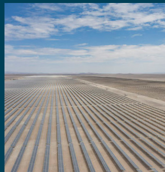
SOL DEL DESIERTO 230 MW Antofagasta, Chile
